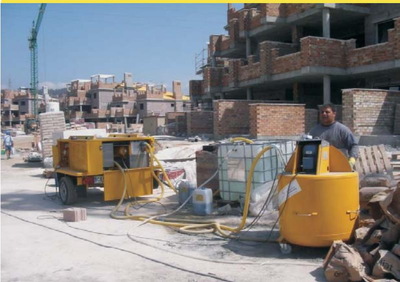
O equipamento AG-300/60 R para o fabrico de betões celulares técnicos é uma fábrica portátil para fazer H.C. “no local”.
