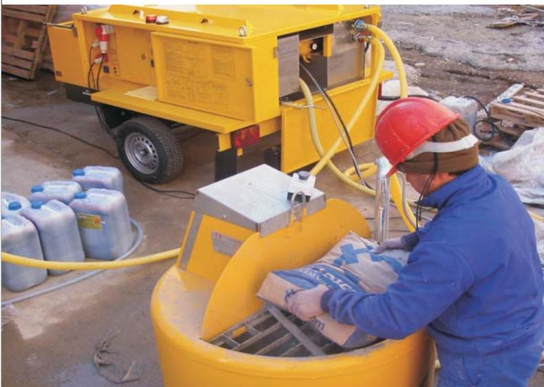
Machine autonome. Sur le chantier, seuls sont nécessaires l'eau, le ciment, l'additif chimique et l'énergie électrique. Simplicité de fonctionnement effectué par 2 opérateurs. Si le pompage s'effectue au débit maximum et/ou pour des ouvrages plus compliqués, il faudra prévoir un supplément de personnel.
